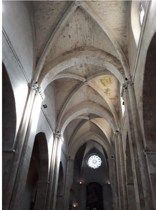
Veduta della navata centrale e delle volte a crociera di Santa Maria Maggiore.
