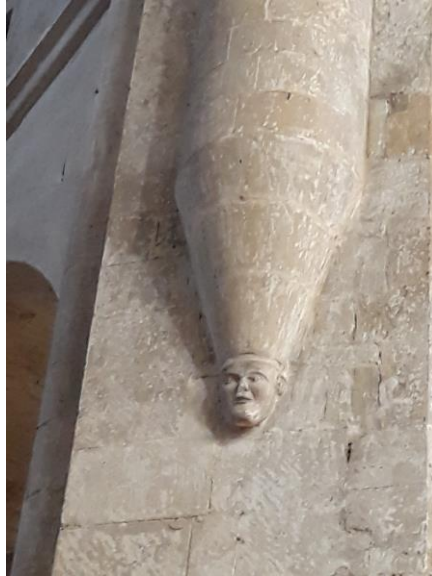
Il culot del lato destro della navata centrale, all'interno di Santa Maria Maggiore.
