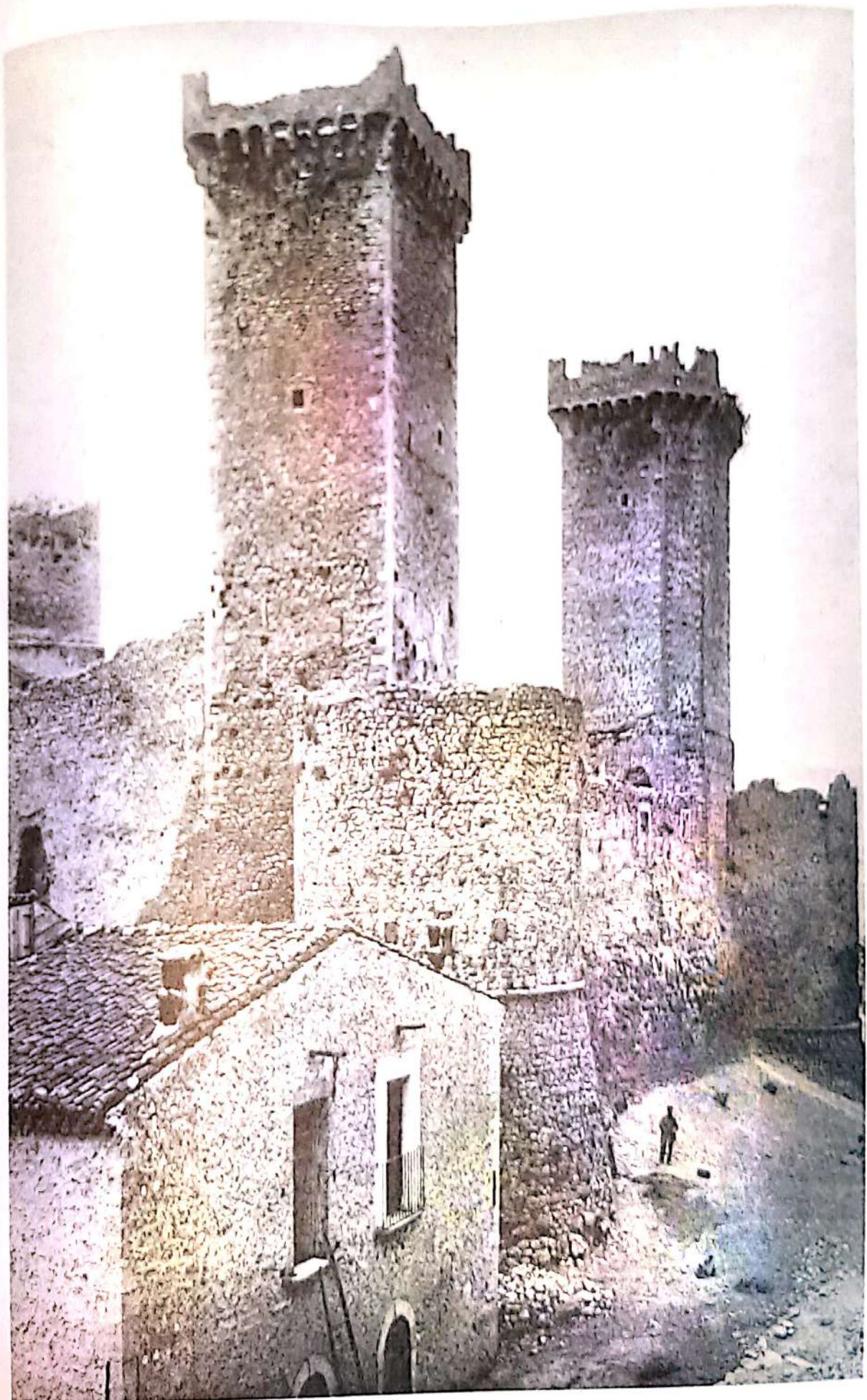
Fig. 889 – Pacentro: Le torri del castello
