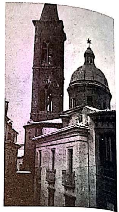
Fig. 913 – Sulmona: Torre della SS. Annunziata - Campanile
