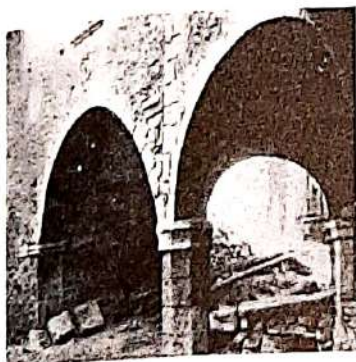
Fig. 852 - Rocca di Mezzo: Sottopassaggi
