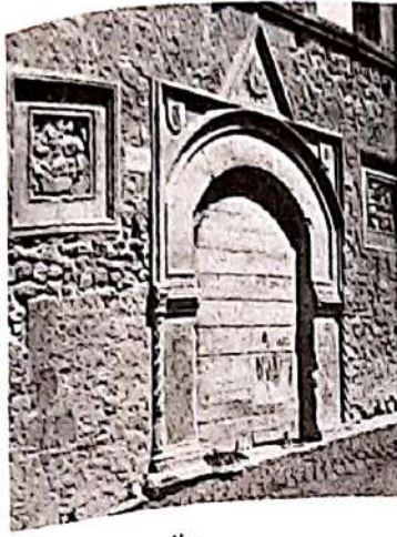
Fig. 839 - Aquila: Casa in via Romana n. 179
