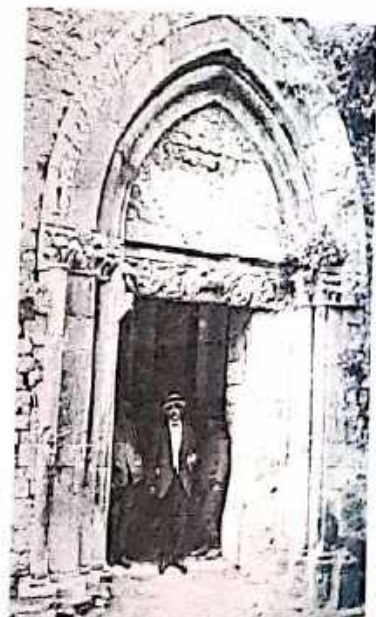
Fig. 603 — Aquila: S. Domenico - Porta di sinistra
