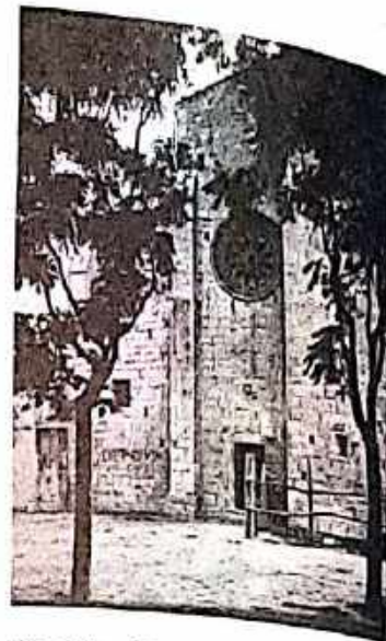
Fig. 459 - Manoppello: S. Maria d'Arabona - Testata del transetto
