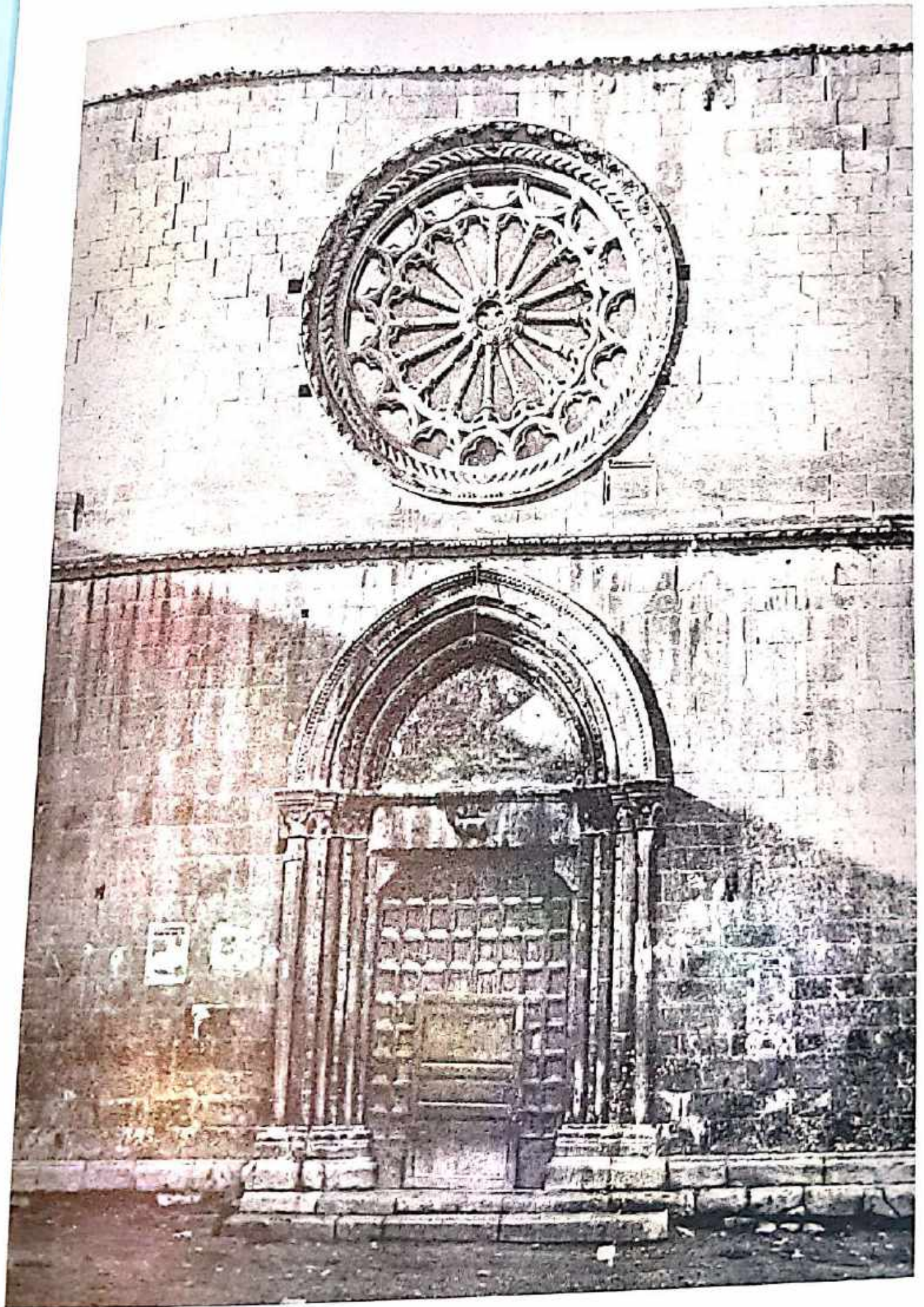
Fig. 660 – Sulmona: S. Maria della Tomba - Parte centrale del prospetto
