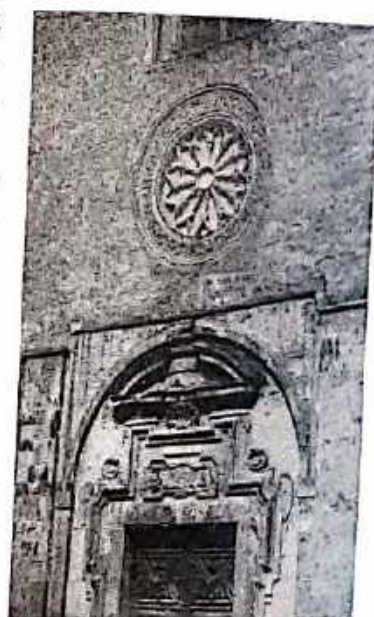
Fig. 681 — Chieti: S. Francesco - Parte centrale del prospetto
