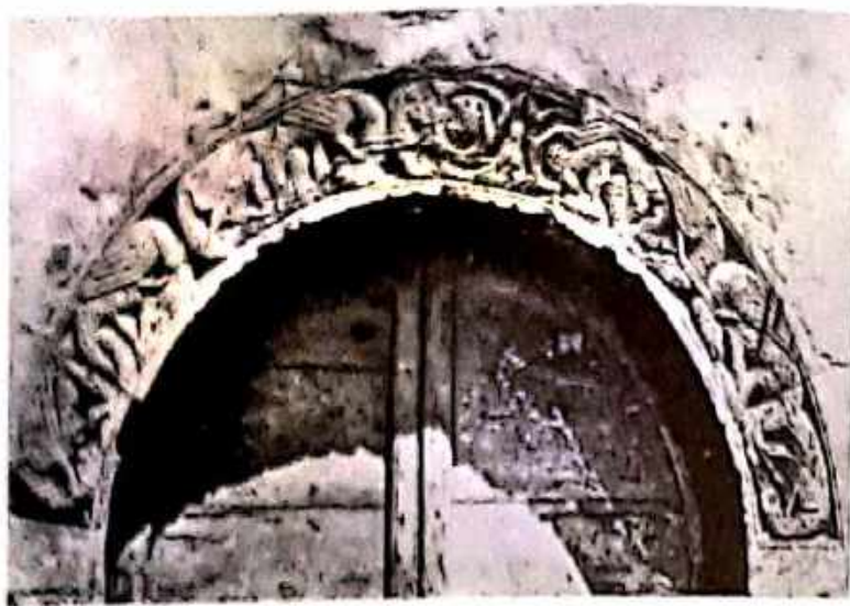
Fig. 565 - Atri: S. Reparata - Archivolto
