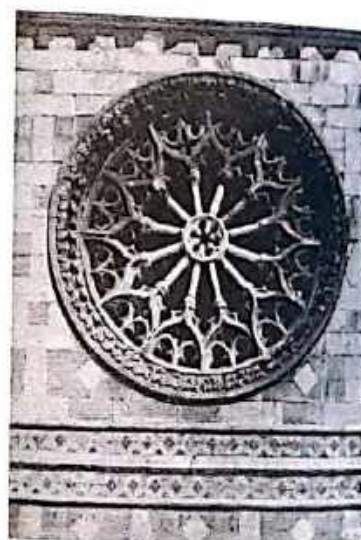
Fig. 614 - Aquila: S. Maria di Collemaggio - Finestra di sinistra
