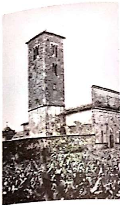
Fig. 206 - Carsoli: S. Maria in Cellis - Torre campanaria
