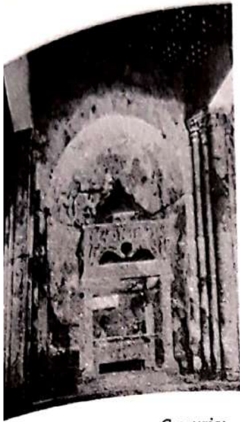
Fig. 345 - Castiglione a Casauria: S. Clemente - Il transetto dopo il restauro
