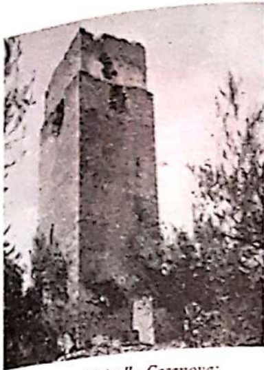
Fig. 248 - Civitella Casanova: Abbazia - Torre del monastero
