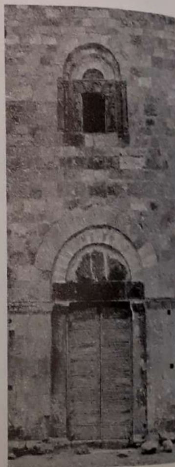
Fig. 339 - Caramanico: S. Tommaso - Particolare del prospetto
