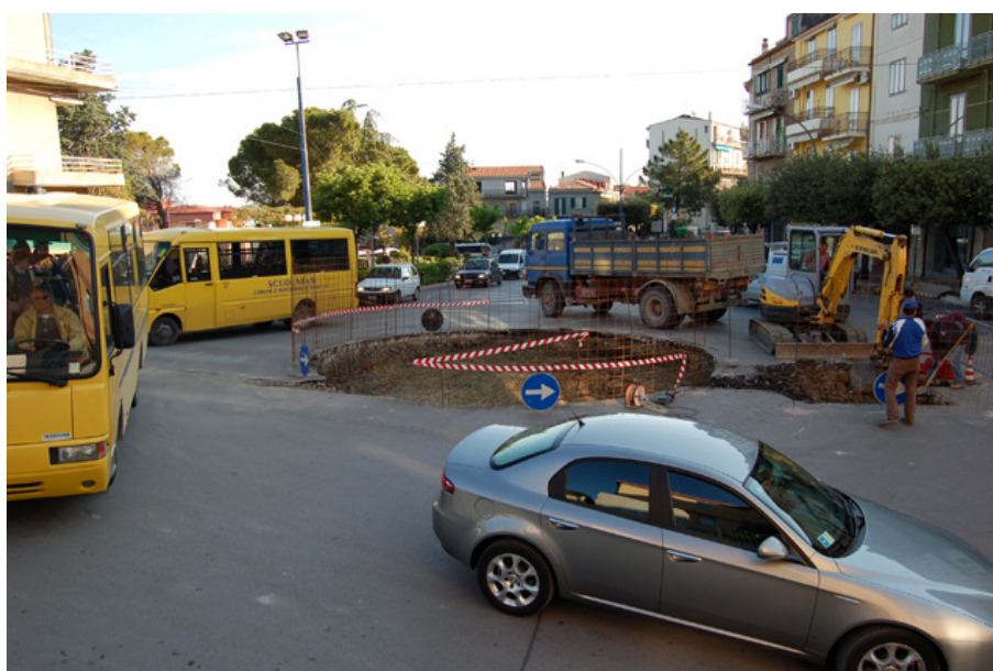
lavori di costruzione della rotatoria in piazza
