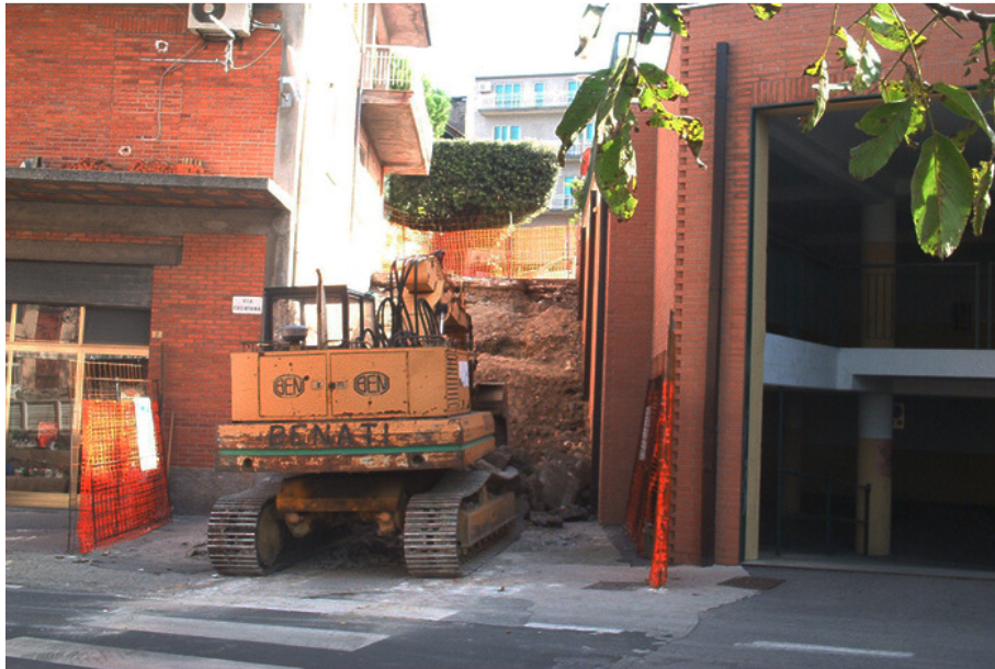
inizio lavori lungo la gradinata accanto al parcheggio multipiano
