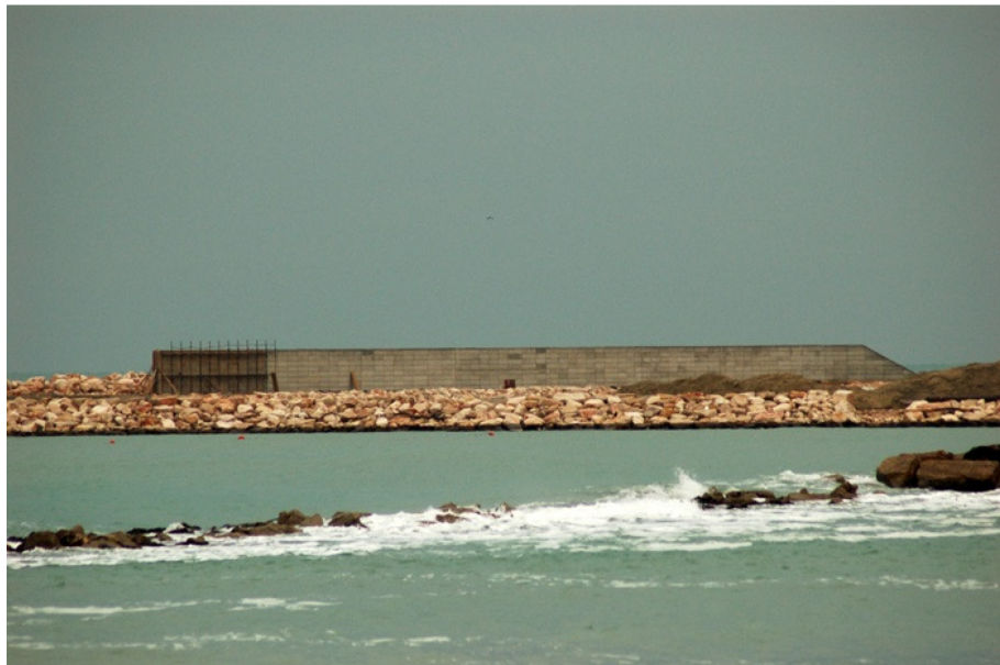
il muro paraonde del porto turistico durante la costruzione
