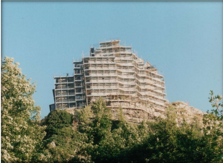
Facciate posteriori e laterali Chiesa Madre. Imponente l'impalcatura montata sulla rupe dei ritagli per l'esecuzione dei lavori di copertura tetti e di pittura. (Foto Lucio Carnevale)
