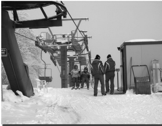
Seggiovia Monte Capraro. Stazione di valle
